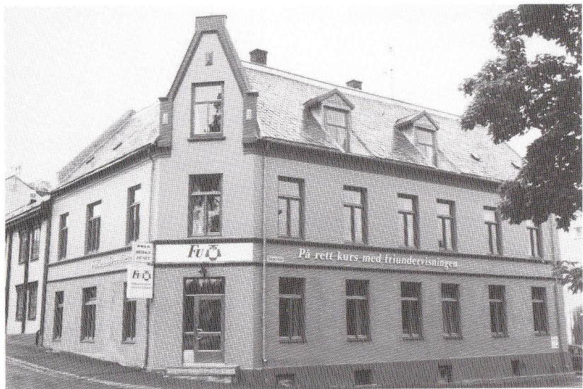
Fasaden av "Bridgehuset" i Grønnegt. 144
