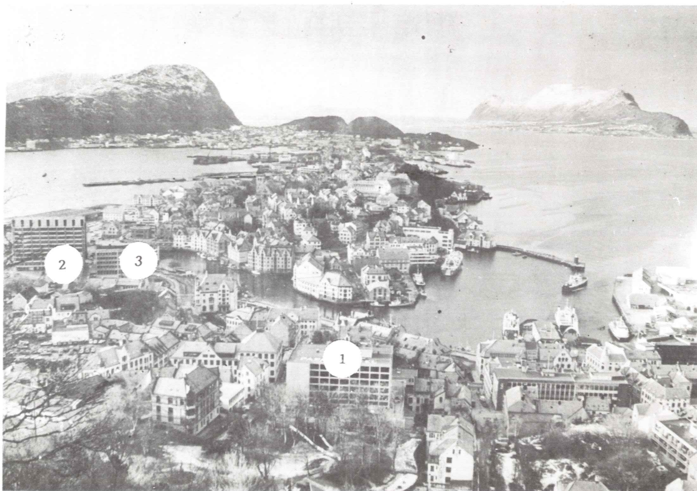
Ålesund sentrum med Parken Hotel (1) – Rådhuset (2) – Sunnmørsbanken (3)
